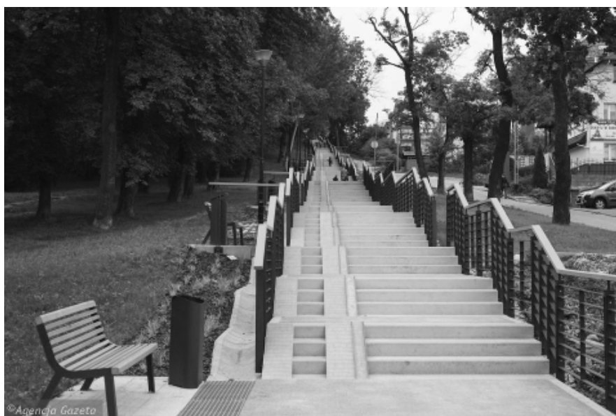
wyremontowane schody łączące ul. Kartuską z ul. Paderewskiego
